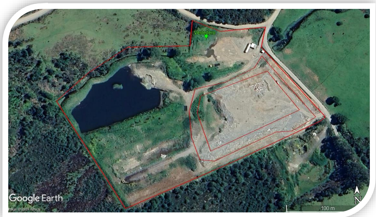
Figura N.º 2 Imagen del vertedero municipal Chonchi
